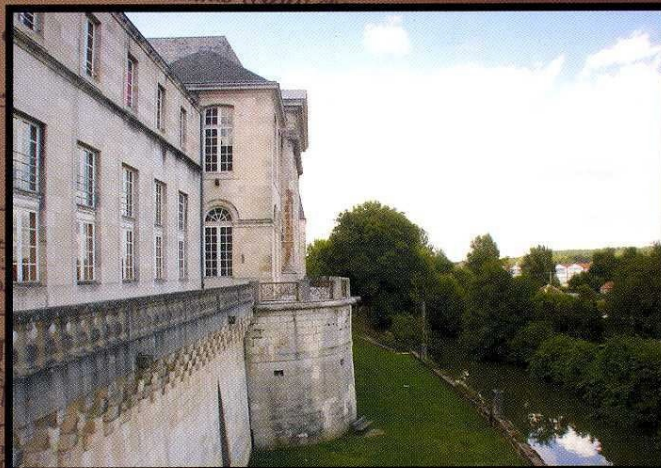
■ Le Château : façade sur jardin
