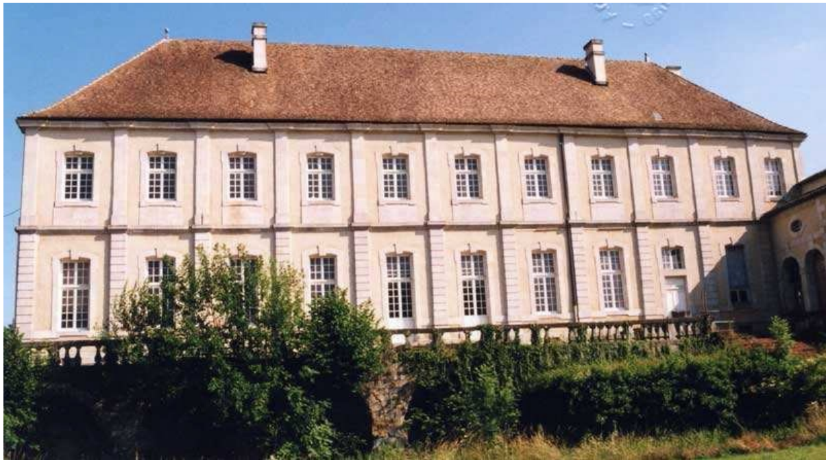
Vue arrière du bâtiment central du prieuré de Breuil, 2001 (157 Fi).
